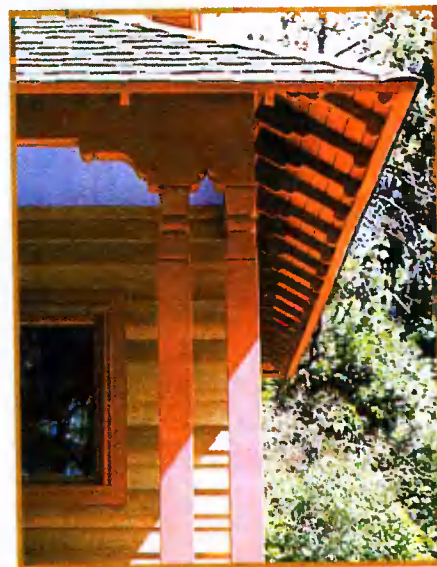
Резные колонны, капители и концы стропил. Последние изготовлены из досок сечением 50х150 мм
