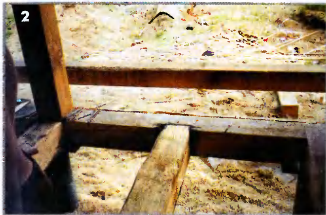
Надежность соединения с хорошо подогнанными шипом и пазом не вызывает сомнения
