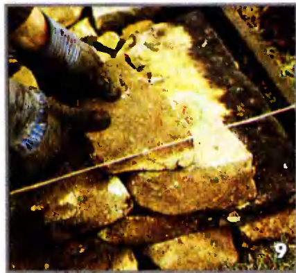
Натянутые между рамами шнуры выполняют функцию направляющих во время кладки. Они же и определяют контуры стены
