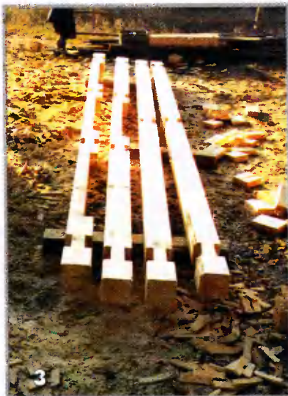
Подготовить брусья одного венца для укладки в сруб можно очень быстро, используя простой способ выборки пазов дисковой пилой
