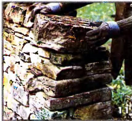
Каждый ряд выкладывают из камней одинаковой толщины. В некоторых случаях можно уложить камень толщиной в два ряда
