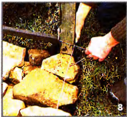
Между вставленными в землю рамами натягивают два шнура, определяющие ширину стены
