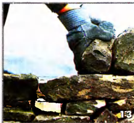
«Венчающие» камни ставят один возле другого на ребро. По углам кладут грубо отесанные угловые камни
