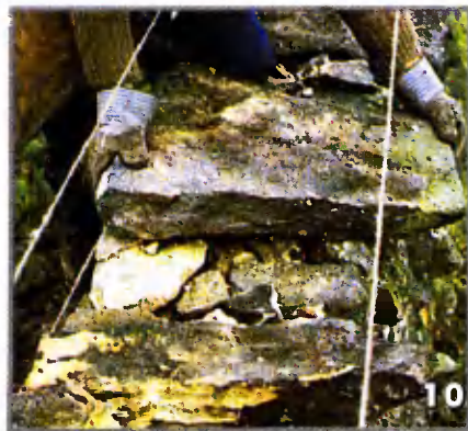
В каждом ряду кладут камни-связи, соединяющие боковые стенки. Они должны плотно прилегать к камням предшествующего ряда. При необходимости их подбивают мелкими камнями
